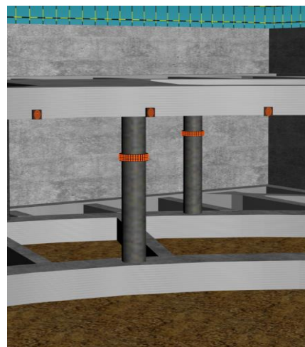
基坑边以及临边构件上挂节能警示 LED 灯
